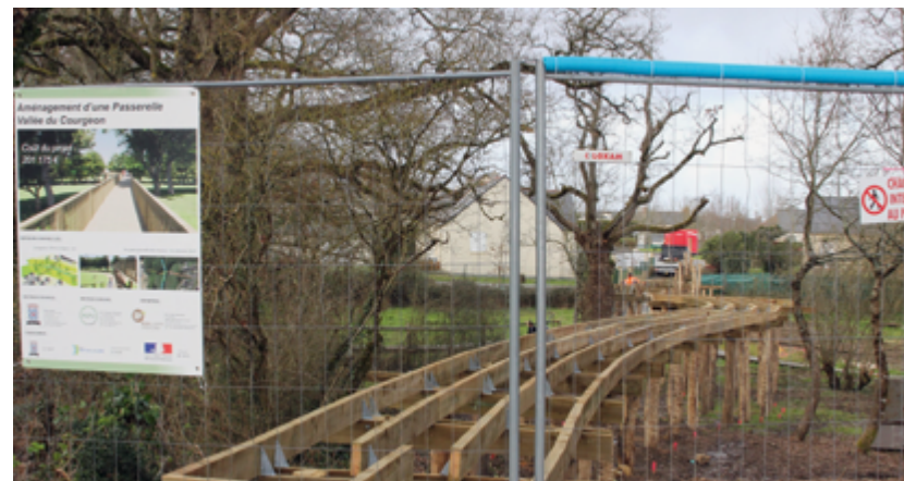
L'état des travaux au 15 mars.
