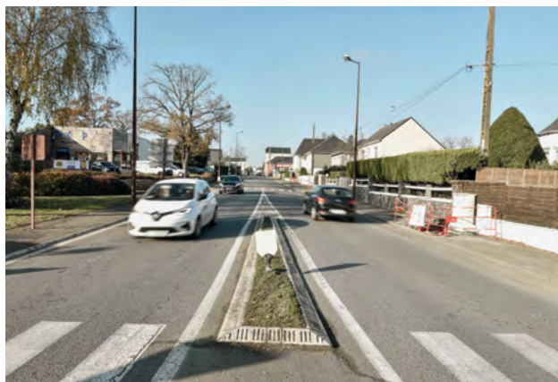
Rue de Nantes
